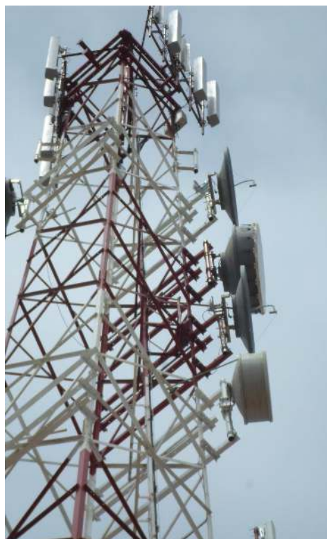
Figura N° 19: Excepciones de mimetización para antenas microondas y satelitales
