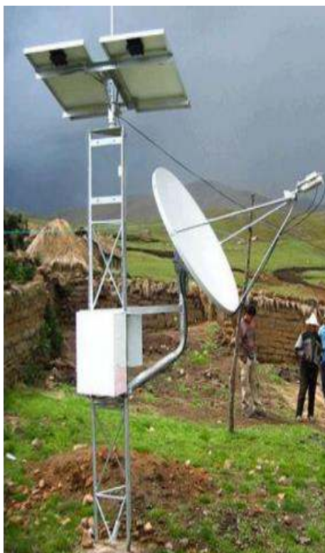
Figura N° 19: Excepciones de mimetización para antenas microondas y satelitales
