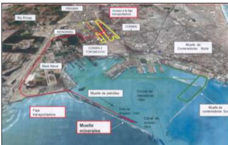
Figura 13. Vista General Faja Transportadora de Minerales
