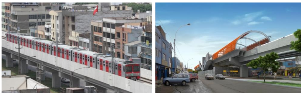
Figura 10. Metro de Lima (Fuente: Portal Web Línea 1 del Metro de Lima)
