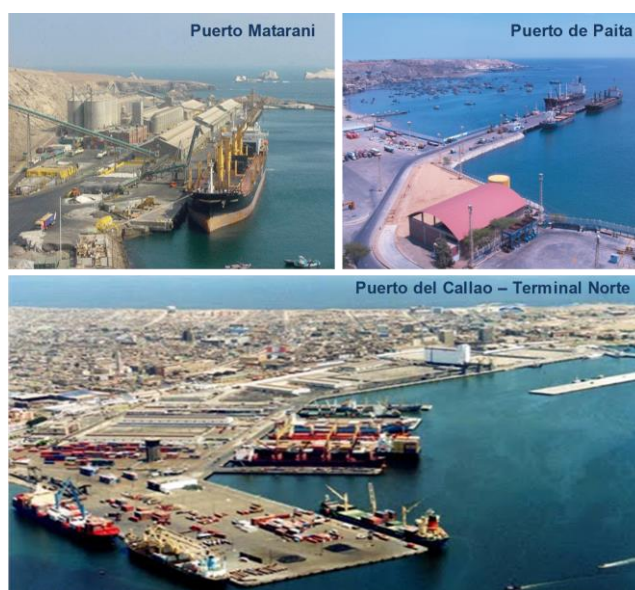
Figura 11. Infraestructura Portuaria Marítima
