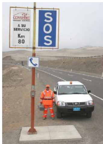
Figura 32. Sistemas de Comunicación SOS (Fuente: Coviperú)
